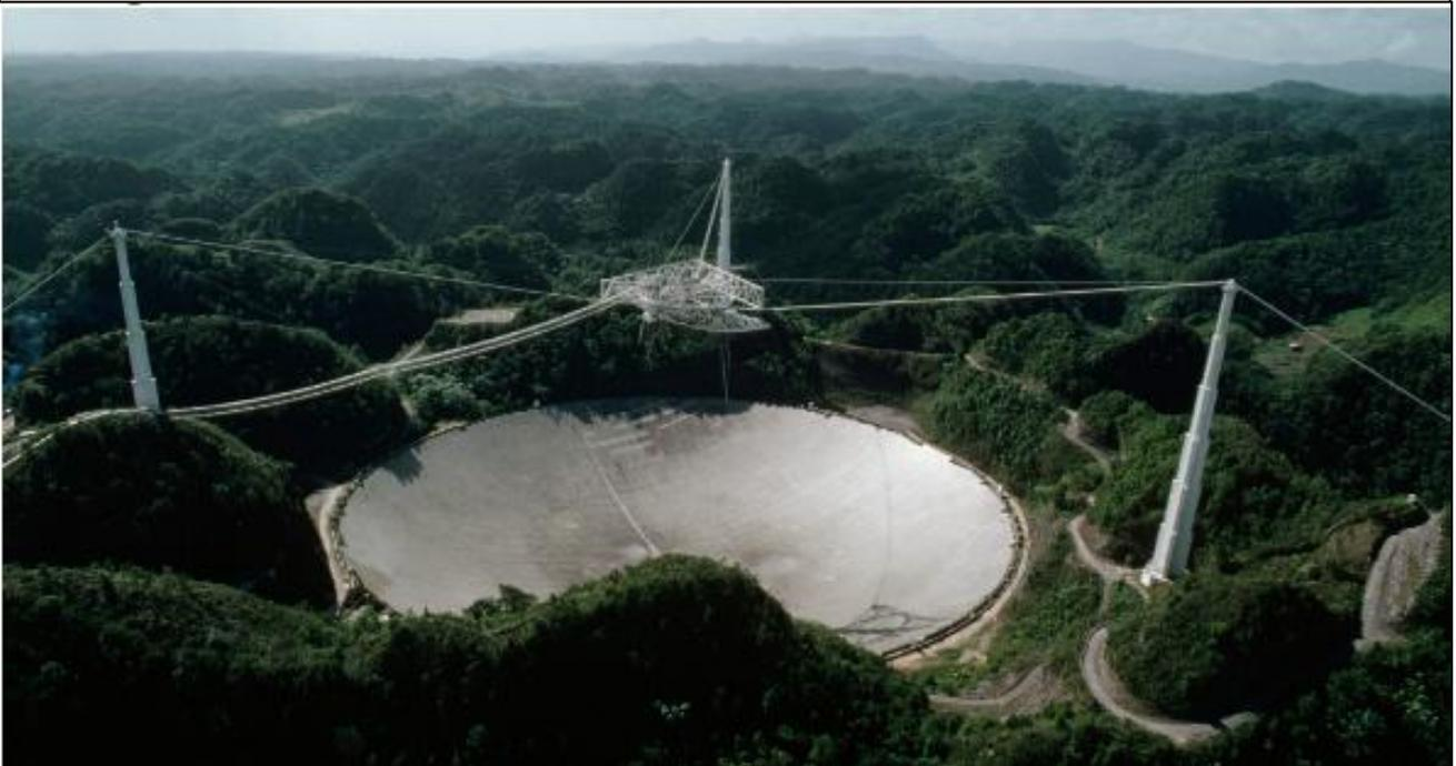
Radiotelescopio di Arecibo (isola di Porto Rico): il diametro è di 305 metri.
